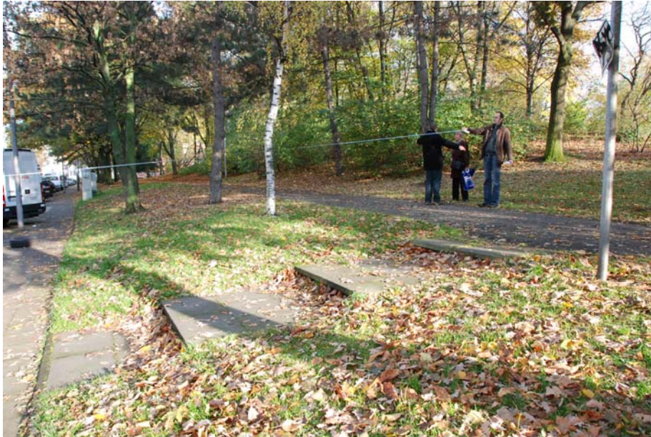
Treppenstufen vom Gehweg zum Hügelweg. Blickrichtung Nord-Ost
